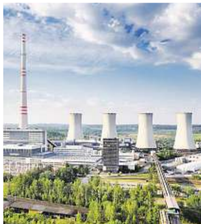
Chvaletice U hnědouhelné Elektrárny Chvaletice má vzniknout zatím největší bateriové úložiště v Česku. Foto: Shutterstock
